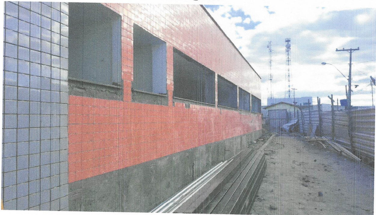
FOTO 04 - PEITORIL LINEAR EM GRANITO OU MÁRMORE, L = 15CM, COMPRIMENTO DE ATÉ 2M, ASSENTADO COM ARGAMASSA 1:6 COM ADITIVO. AF_11/2020
